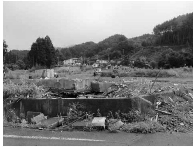
家屋は流され、土台だけが残る住宅跡。
